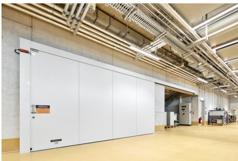
Bild 13: Geschützter Brandabschnitt: Hinter dem Hörmann Feuerschutz-Schiebetor befindet sich der Lastenaufzug.
