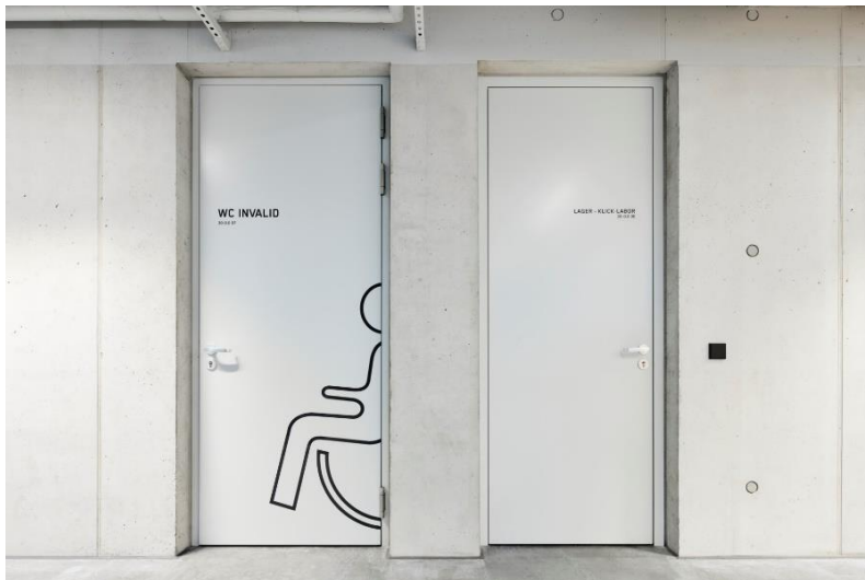
Bild 12: Die Stahl-Objekttüren STS von Hörmann sind farblich unauffällig in die Wände mit Sichtbeton integriert.
