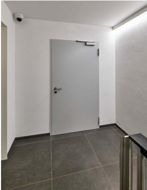
Bild 6: Hörmann Stahlblechtüren mit Brandschutzausstattung kommen im Keller zum Einsatz.
