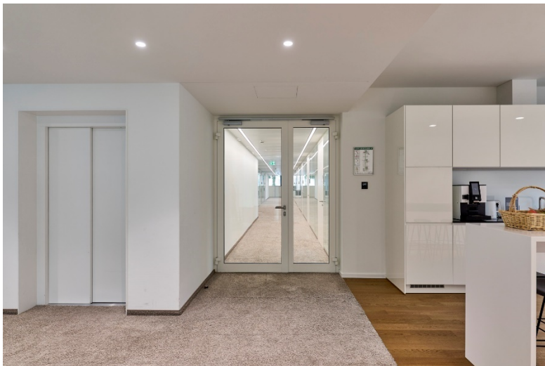
Bild 5: Durch die vollverglaste T30 Rohrrahmenobjekttüren aus Aluminium von Hörmann gelangt natürliches Licht ins Innere und Blickbeziehungen entstehen.
