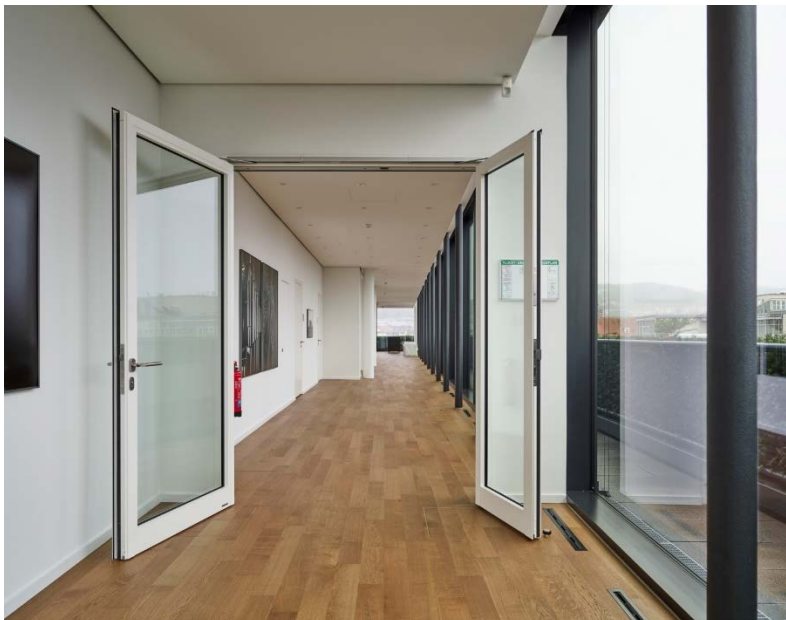
Bild 7: Für die maximale Durchgangsbreite kann auch der Stehflügel der 2-flügligen Aluminium-Rohrrahmenobjekttüren geöffnet werden.
