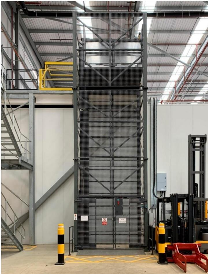
**Bild 3:** Selbsttragend, kompakt und schnell installiert: der Lastenaufzug von Hörmann. Das Sicherheitsgitter wird mechanisch und elektrisch verriegelt und sorgt für Schutz.
