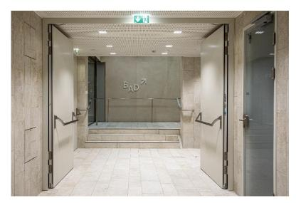
**Bild 6:** Die 2-flügligen Stahl-Objekttüren STS von Hörmann geben einen großen Durchgang frei. Beide Türflügel sind mit dem Stangengriff EPN 900 versehen, die ein einfaches Öffnen auch in Paniksituationen ermöglichen. **Foto: Gerd Kressl**
