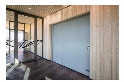
**Bild 8:** Im Brandfall schließt das Feuerschutz-Schiebetor mit Nischenklappe von Hörmann und trennt Brandabschnitte voneinander ab. Im Normalbetrieb liegt es platzsparend in der Wand und sorgt so für die volle Durchgangsbreite. **Foto: Gerd Kressl**
