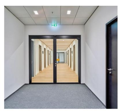
**Bild 5:** Im Omniturm in Frankfurt sind verglaste Rohrrahmenobjekttüren aus robustem Stahl von Hörmann zum Einsatz gekommen. Die feuerhemmenden T30 Brandschutztüren teilen die Flure in Brandabschnitte.
