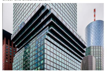
**Bild 2:** Der "Hüftschwung" zwischen Geschoss 15 und 23 macht deutlich, wo sich die Wohnungen des Omniturms befinden. Er kragt bis zu vier Metern aus.
