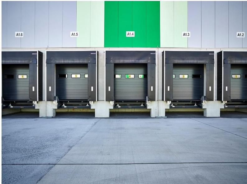
**Bild 2:** An allen Toren kommen Planentorabdichtungen von Hörmann zum Einsatz, die sich flexibel an die Konturen verschiedener LKW anpassen und damit für eine zugfreie Be- und Entladung sorgen.
