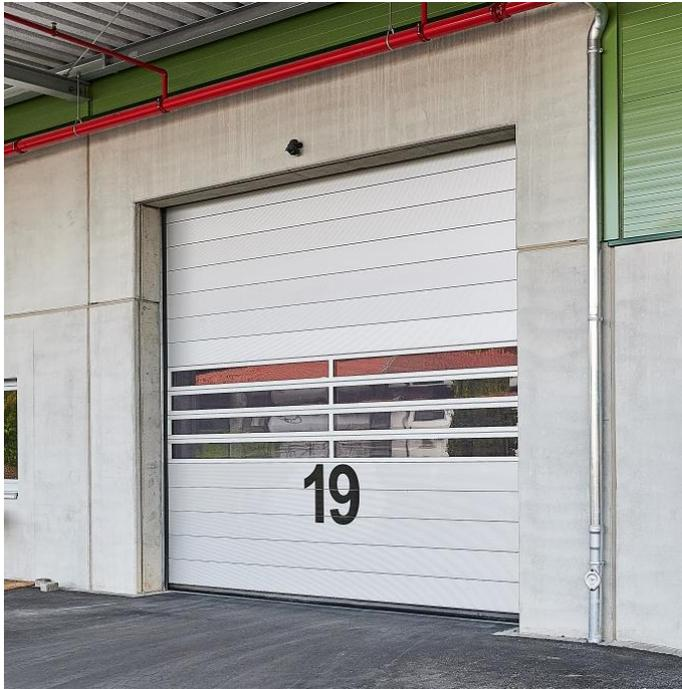
**Bild 3:** An den Außenseiten des Wareneingangs und des Kleinteilelagers kommen robuste und elektrisch angetriebene Hörmann Spiraltore vom Typ HS 7030 PU 42 zum Einsatz. Die Tore bieten nach Angaben des Unternehmens neben einer hohen Öffnungsgeschwindigkeit auch gute Dämmeigenschaften.
