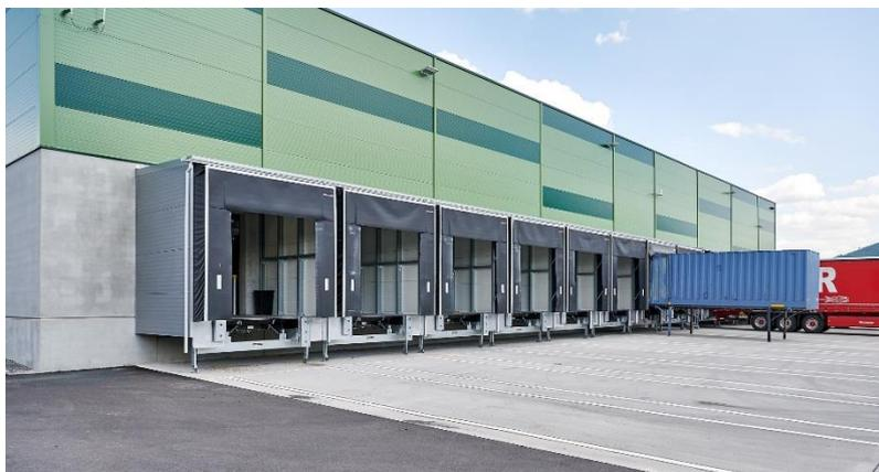
**Bild 6:** Um die Hallenfläche bis zu den Außenwänden voll nutzen zu können, kommen an allen 14 Sektionaltoren von Hörmann im Warenausgang Vorsatzschleusen vom Typ LHP 2 zum Einsatz.
