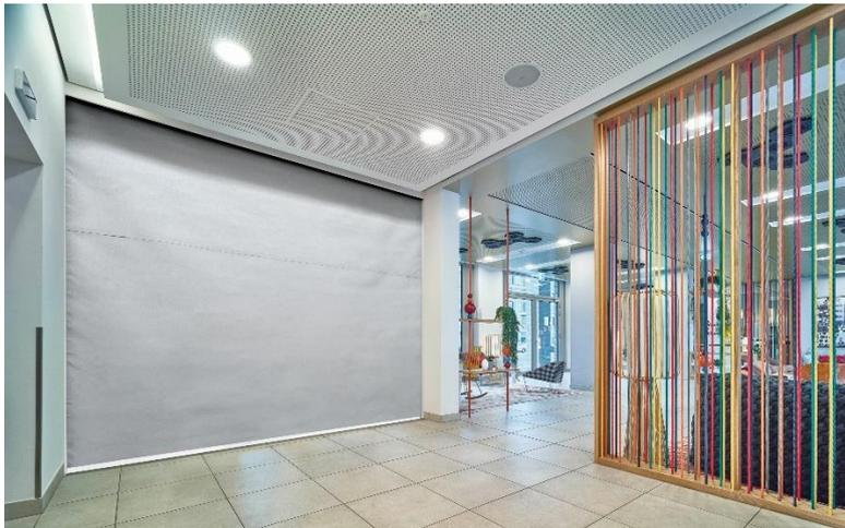
**Bild 2:** Der FlexFire ist bis zur Feuerbeständigkeitsklasse E120 verfügbar. Der textile Feuerschutzvorhang eignet sich vor allem für die Trennung von großen Brandabschnitten in öffentlichen Gebäuden, Hotels oder Kaufhäusern.
