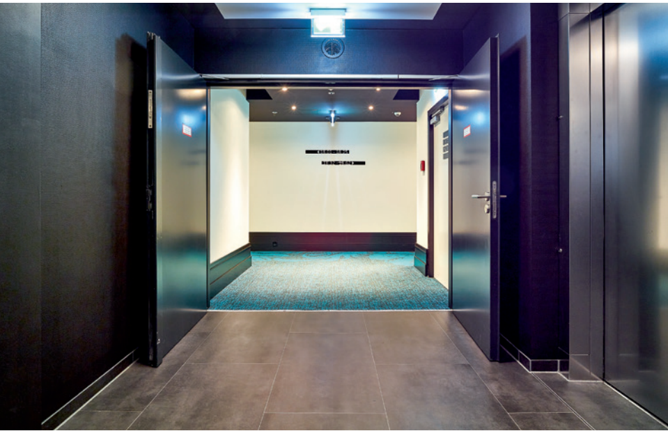
Doppelfügelige Stahltüren trennen den Fahrstuhlbereich von den Fluren der Gästezimmer.
