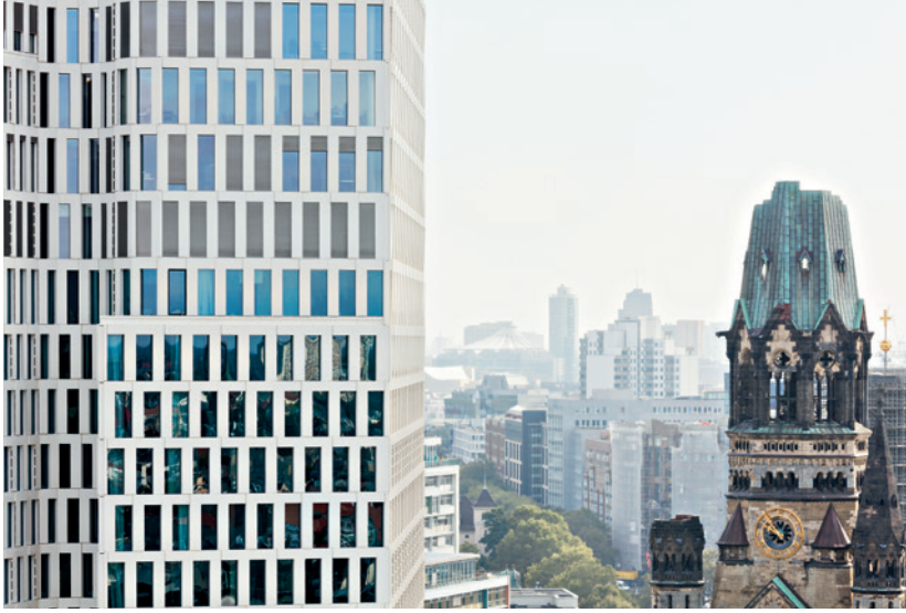
Alt und Neu scheinbar dicht beieinander: das „Upper West“ und die Ruine der Gedächtniskirche.
