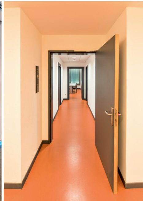
Brandschutztür im Flur.
