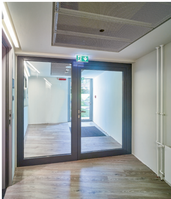
Verglaste Rohrrahmenelemente lassen Licht ins Innere.
