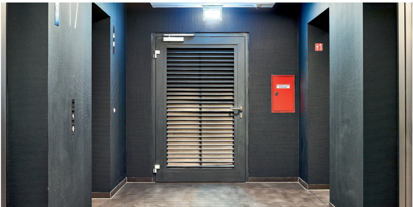
Blick-, aber nicht luftdicht: Die Sonderanfertigung besteht aus einem Hörmann Rohrrahmenelement und einem Gittereinsatz von Renson.
