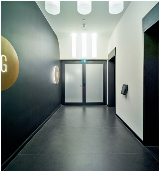
Opake Rohrrahmenelemente dienen als Sichtschutz.
