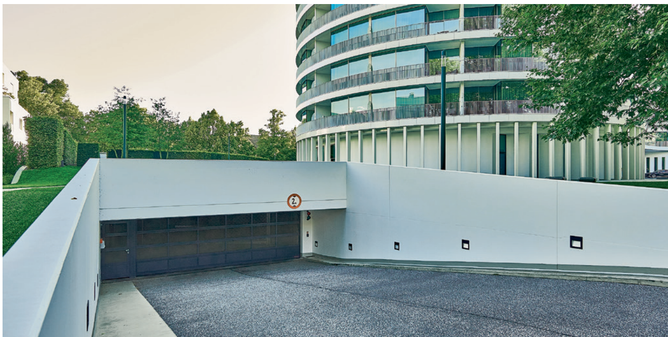
Die Zufahrt zur Tiefgarage wird von einem Hörmann-Tor mit Streckmetall abgeschlossen.
