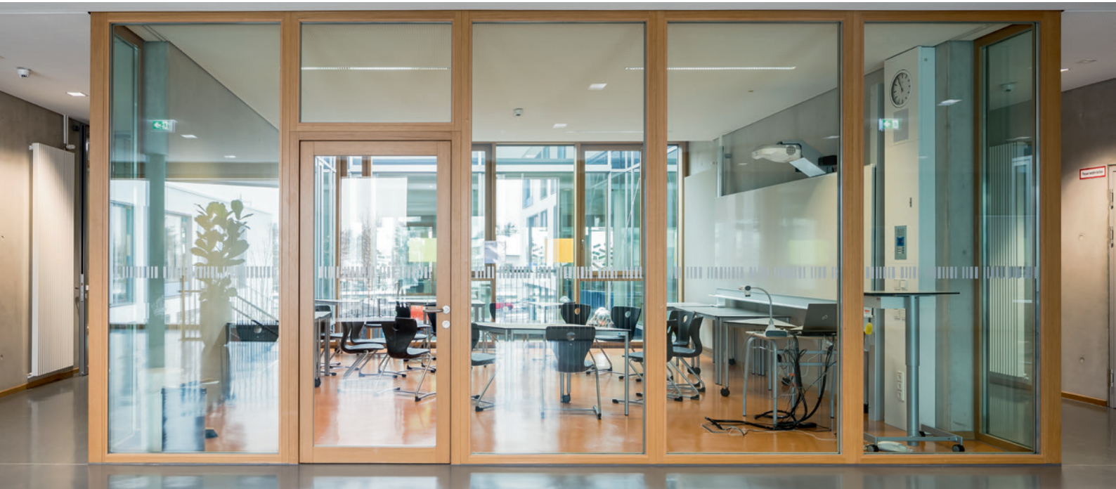
Während die Türen ein Schalldämmmaß von R_{w,P} = 37 dB erreichen, haben die feststehenden Elemente bis zu R_{w,P} = 53 dB.
