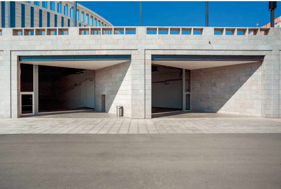
Die Zufahrt zur Tiefgarage wird von Rollgittern abgeschlossen.
