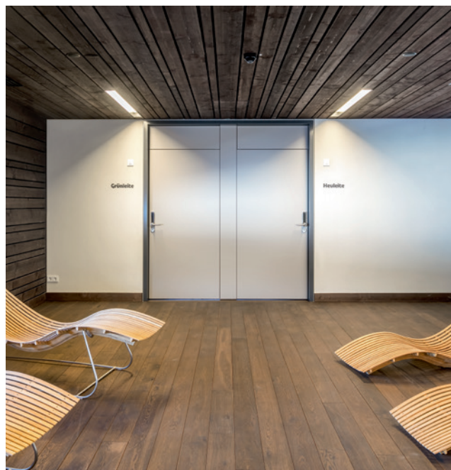
Zwei Türen – optisch durch eine umlaufende Zarge zusammengefasst.
