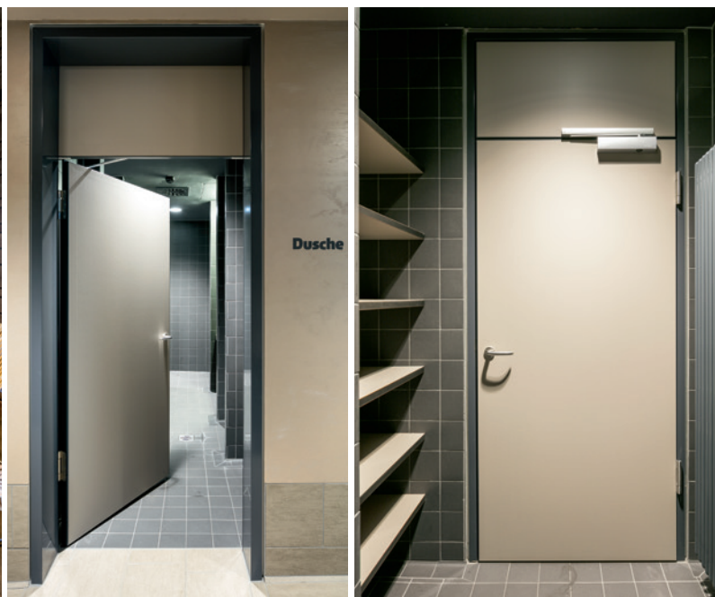
Nassraumtüren werden frei von Holz und Holzwerkstoff gefertigt.
