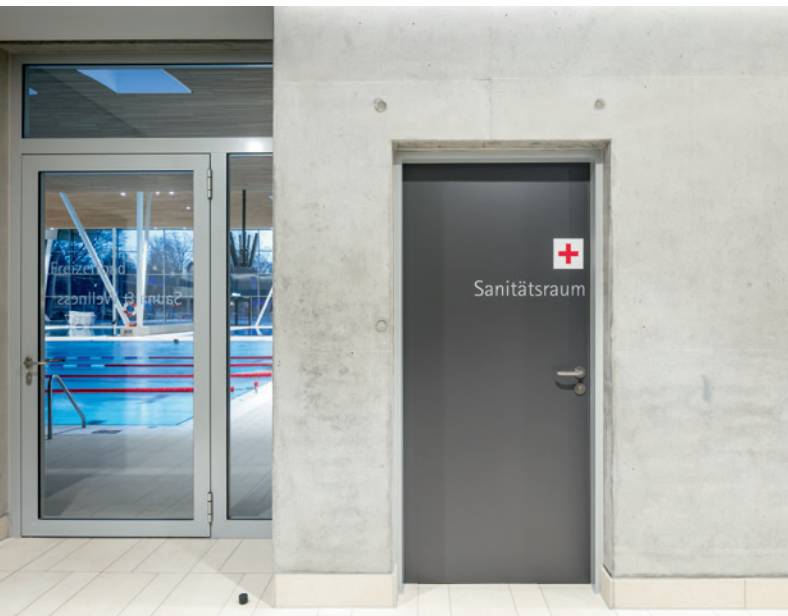
Die meisten Nassraumtüren verfügen über eine Aluminiumzarge.
