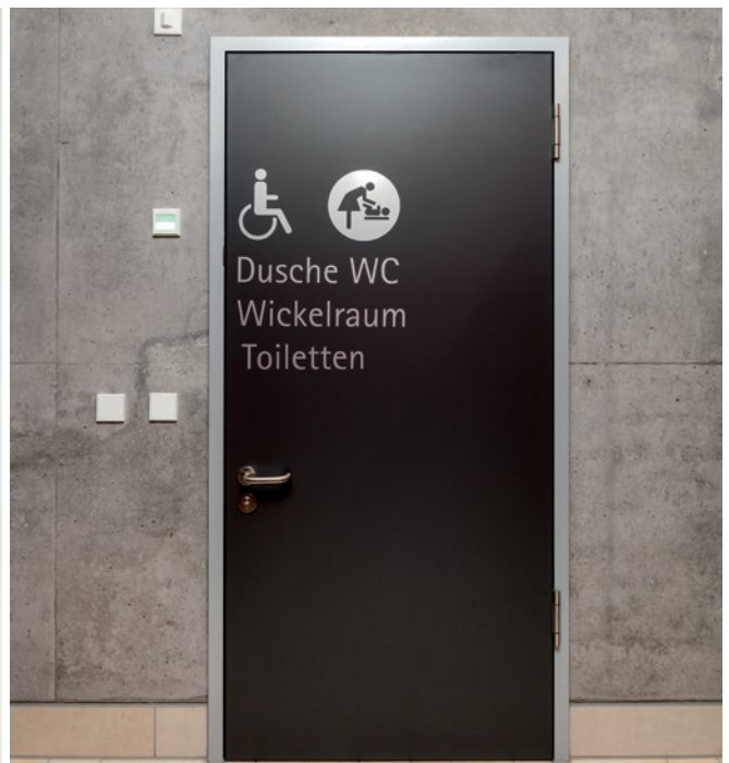
Farblich abgesetzte Zargen bilden einen Rahmen um die barrierefreie Tür.
