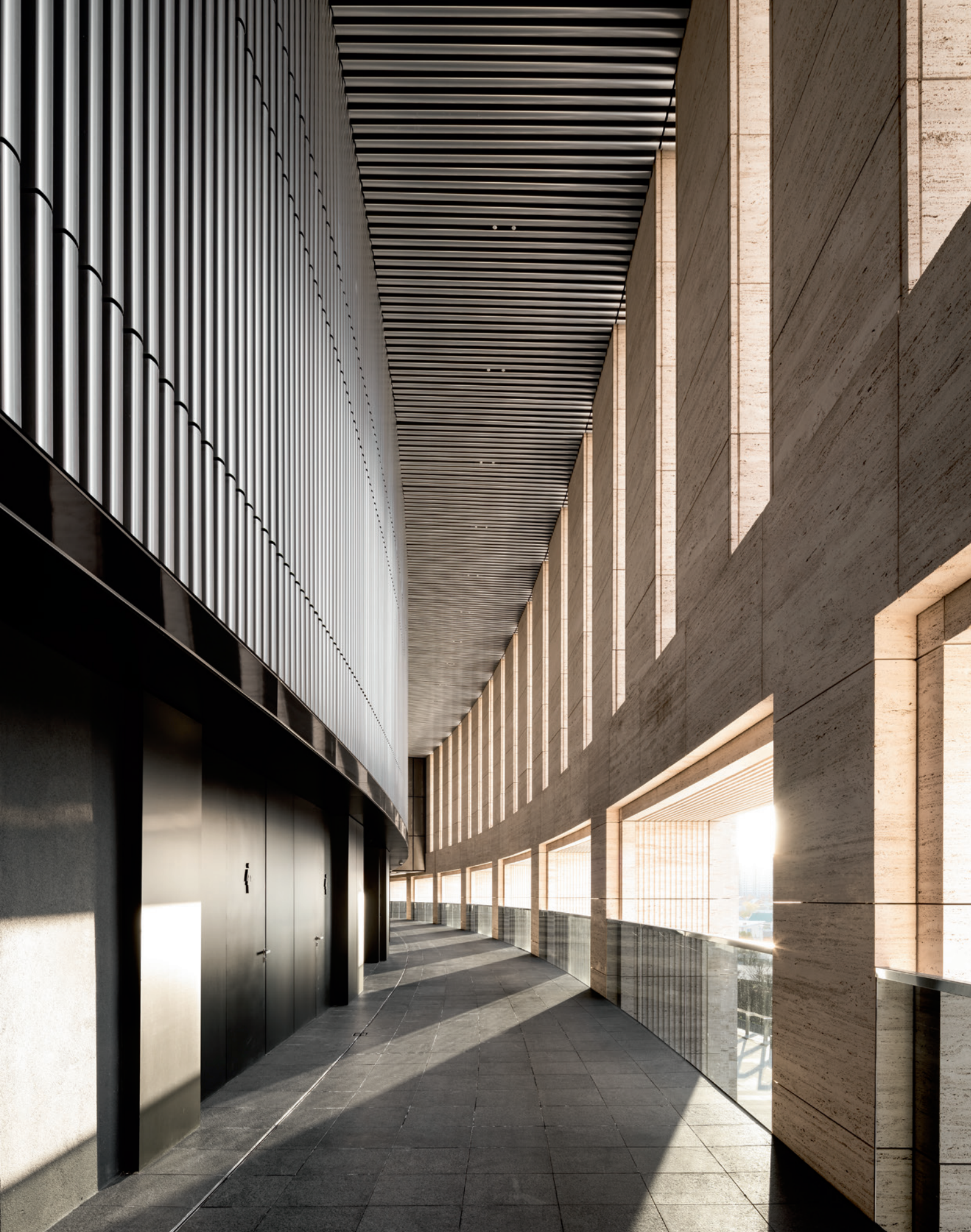
Edle Materialwahl: Bodenplatten aus schwarzem Basalt sowie Lamellenverkleidung aus eloxiertem Aluminium sind in Stadien selten zu finden.
