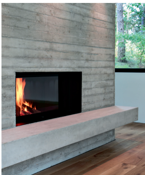
Auch im Inneren setzt Sichtbeton Akzente.
