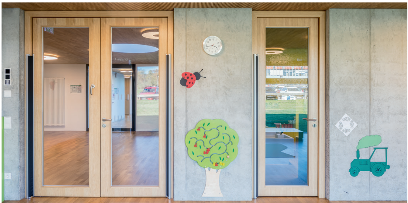
Damit die Kinder sich nicht verletzen, sind die Schallschutztüren mit Fingerschutzrollos und abgerundeten Kanten ausgeführt.
