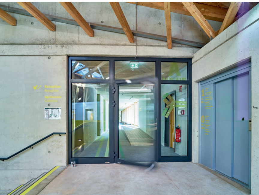
Die Rohrrahmenelemente vereinen Transparenz mit Brandschutzanforderungen.
