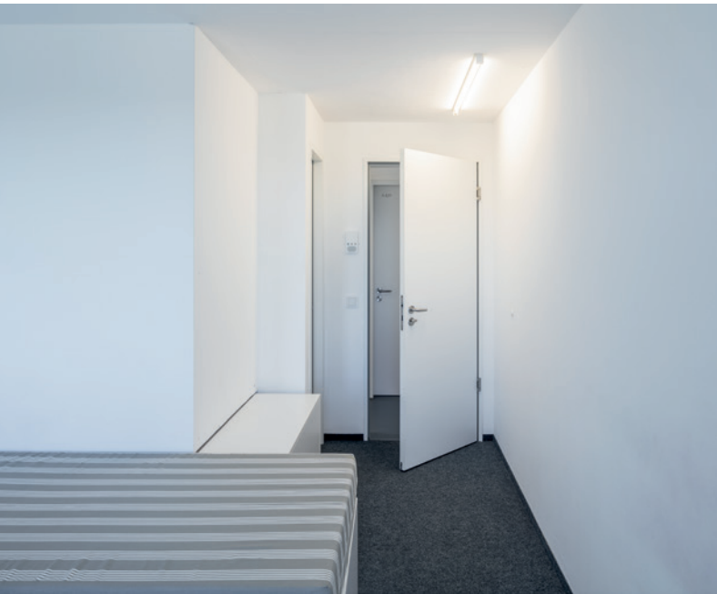
Die Zimmertüren mit Schallschutzanforderung haben eine Stahlzarge.
