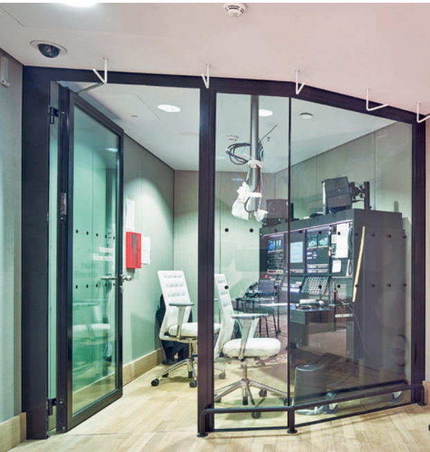
Rohrrahmenelemente begrenzen den Regieraum.
