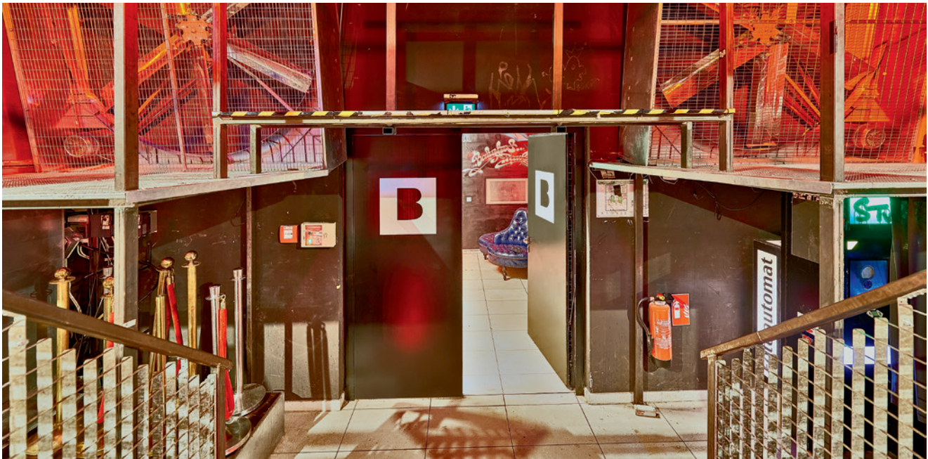
Die doppelflügelige T30 Feuer- und Rauchschutztür von Hörmann bildet den Hauptzugang in den Club „Bahnhof St. Pauli“.
