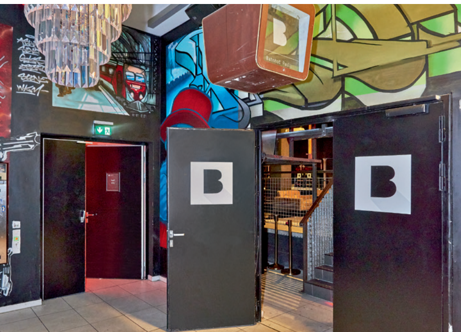
Im Hintergrund führt ebenfalls eine T30 Feuer- und Rauchschutztür zum Treppenhaus.
