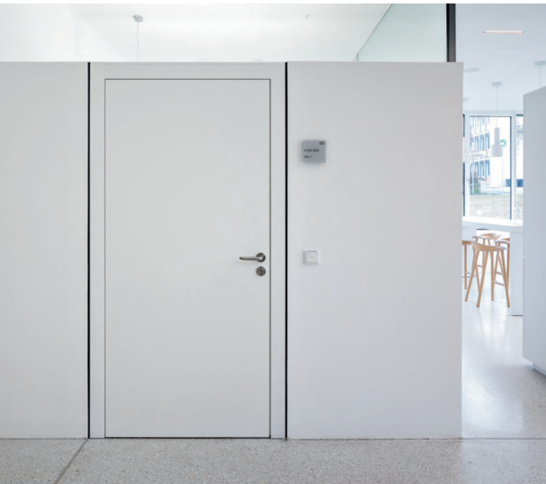
Flächenbündig schließen die Bürotüren von Schörghuber mit der Wand ab. Die dezenten schwarzen Fugen inszenieren die Türen – auch zu den Nebenräumen.
