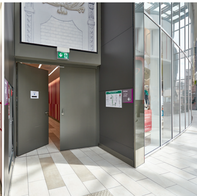
Zweiflügelige Feuer- und Rauchschutztüren schützen die Fluchtwege in den Außenbereich.
