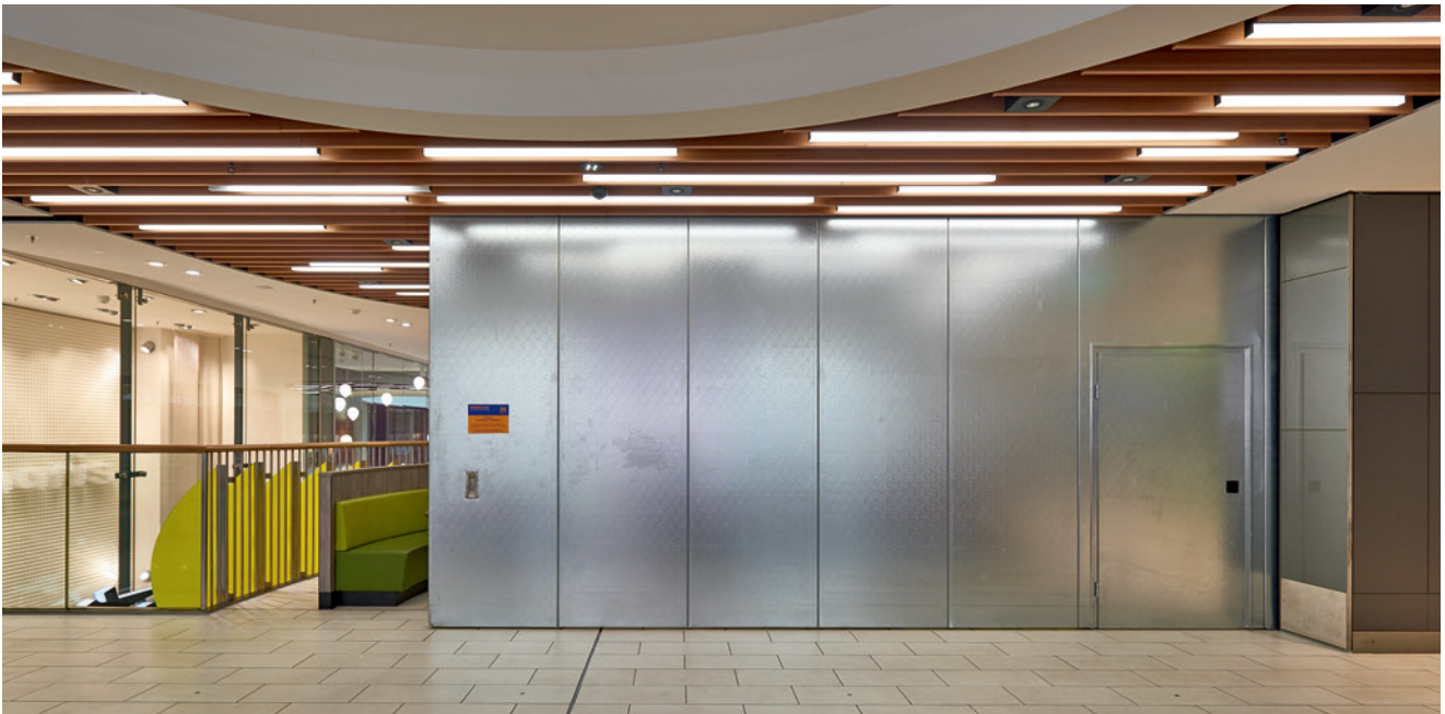
Feuerschutz-Schiebetore fahren im Brandfall aus der Wand und trennen die einzelnen Brandschutzzonen voneinander ab.
