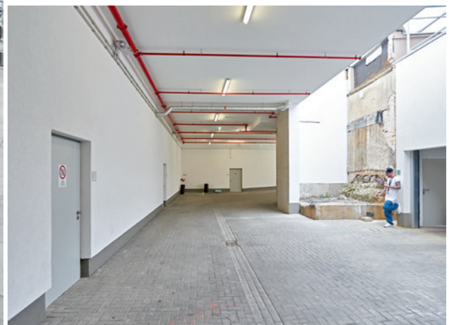
Außentüren befinden sich im teilüberdachten Innenhof der Anlieferung.
