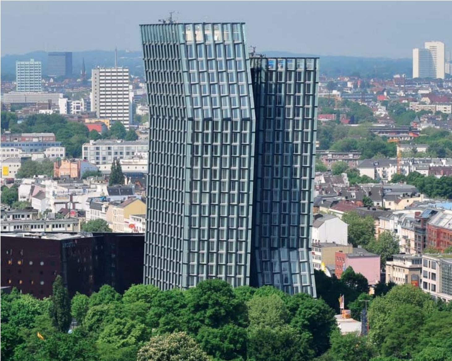
Ein vor die Fassade gesetzter Metallrahmen, der dem schrägen Lauf der Stützen folgt, erzeugt räumliche Tiefe.
