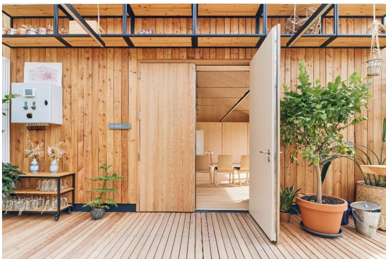
Bild 6: Die doppel­flügelige Tür von Schörghuber zum Atelier setzt sich vom astigen Holz der rauer­en Wand ab.
