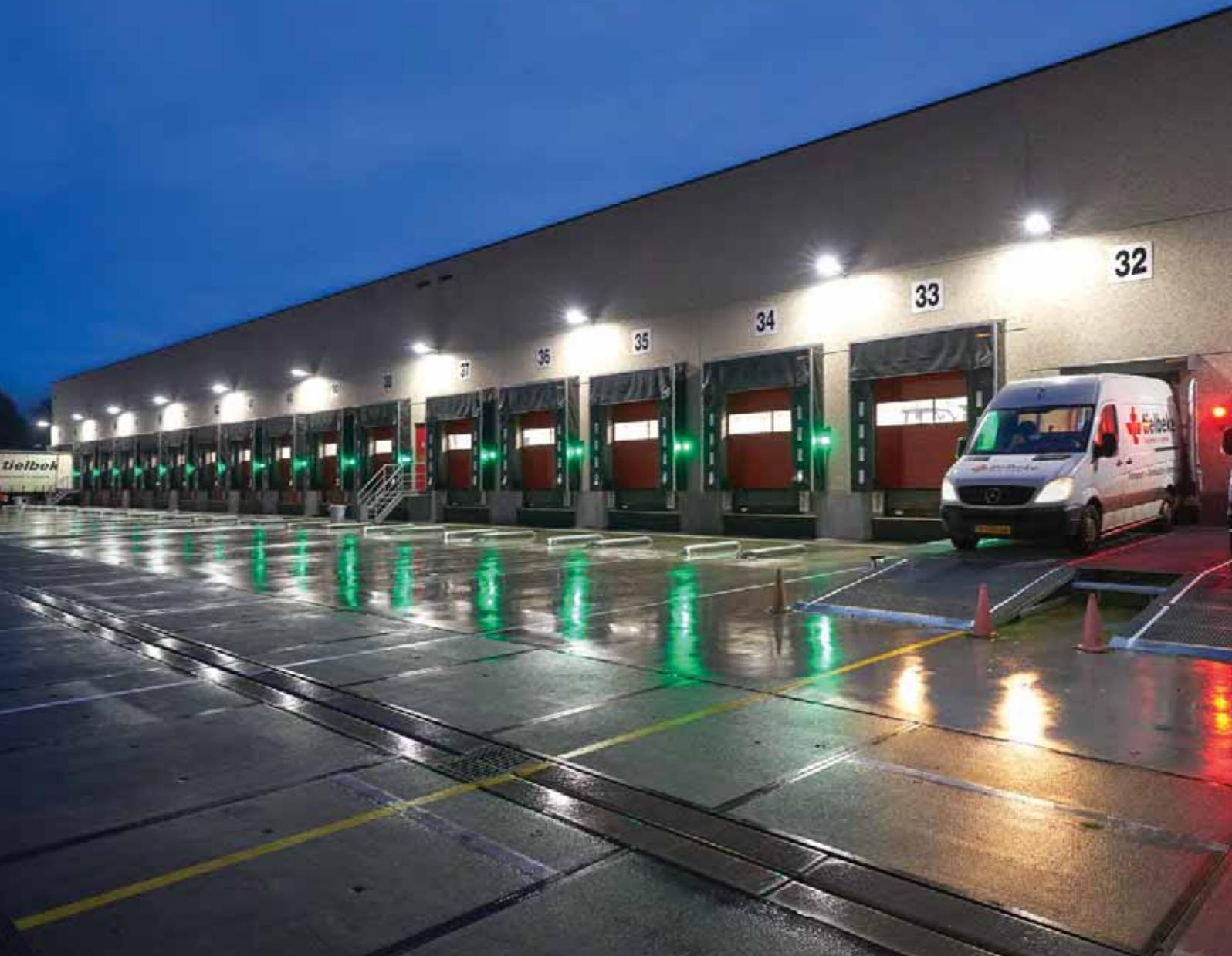
OBEN. Signalleuchten im Außenbereich kommunizieren mit international verständlichen Ampelfarben mit dem Fahrer.
