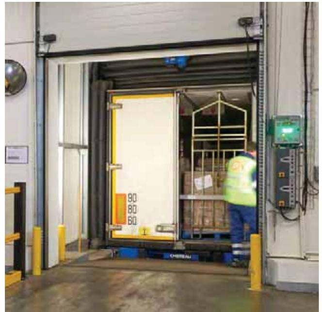
**SCHNELLIGKEIT.** Mit dem DOBO-System werden ca. 5 Minuten pro LKW beim Andocken eingespart, da der Fahrer nicht aussteigen muss, um vorher die Türen zu öffnen. Wechselbrücken können zudem abends andockt und morgens direkt entladen werden.
