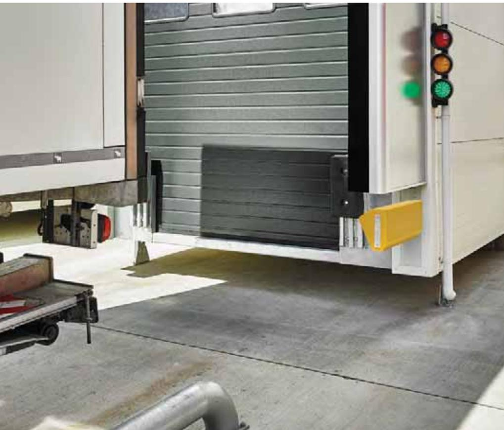
OBEN LINKS. Die Radführung aus Stahl unterstützt den Fahrer beim Andocken. Der Radkeil WSPG mit Sensor gibt die Laderampe erst bei Kontakt zum Reifen frei.
