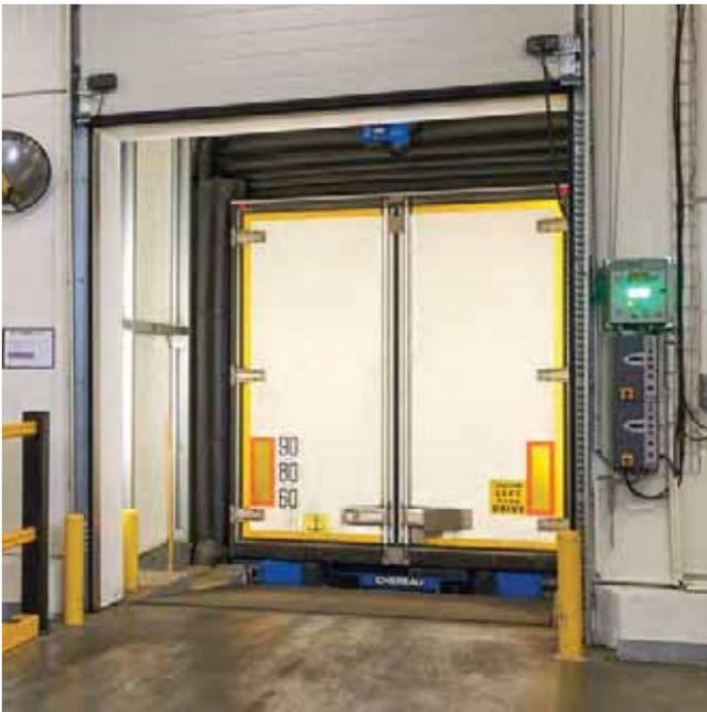
Mit dem DOBO-System kann der LKW mit geschlossenen Türen andocken und diese nach dem Öffnen des Tors in der Halle öffnen und abstellen.
