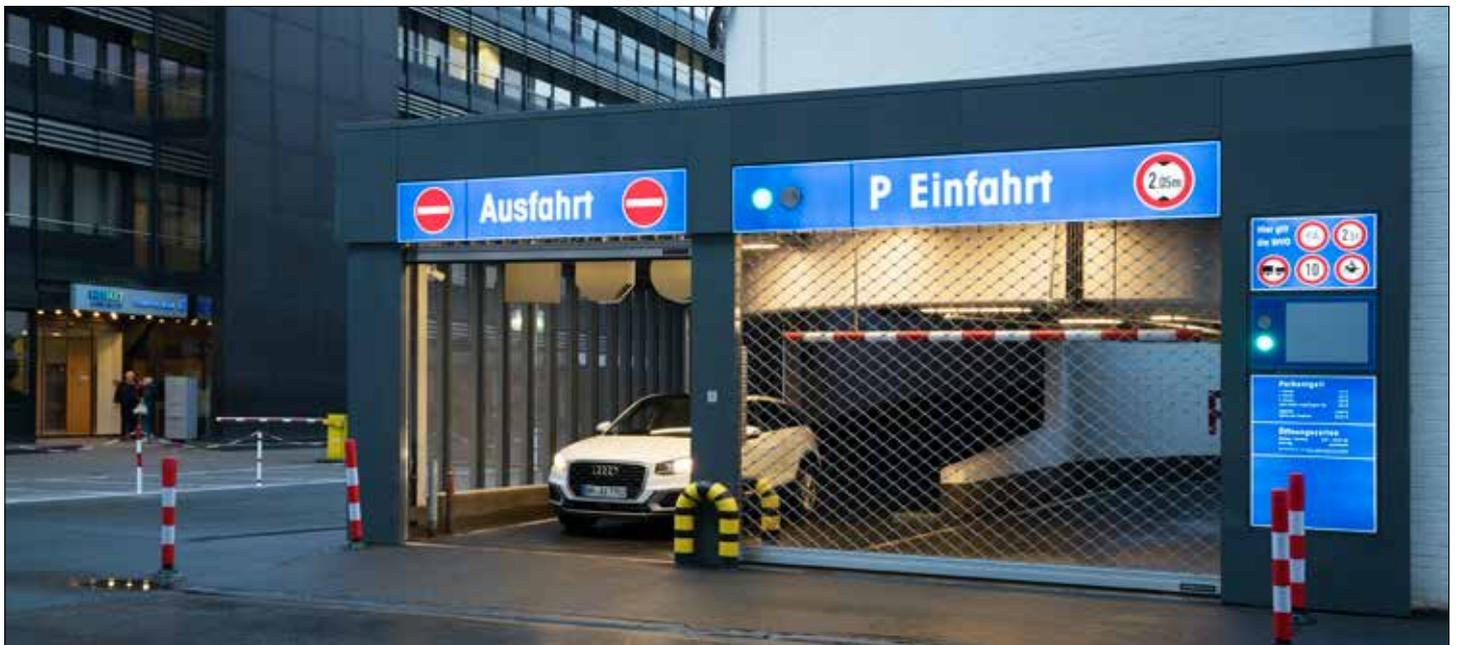
**ZUVERLÄSSIGE SICHERHEIT.** Bei Toren mit Impulsfolgesteuerung überwachen Sicherheitssysteme mit integrierter Selbsttestung das Einhalten der Vorgaben für die dynamischen Schließkräfte. Kraftbetätigte Rollgitter in öffentlichen, leicht zugänglichen Bereichen, in denen sich auch Kinder aufhalten und sich am Rollgitter hochziehen lassen könnten, sind mit besonderen Sicherheitseinrichtungen wie einer Einzugssicherung oder einer Kraftbegrenzung in Richtung Tor-AUF ausgestattet.
