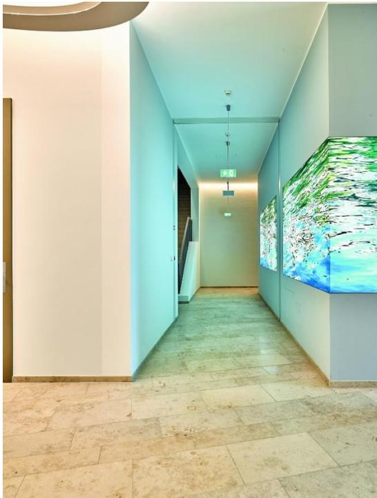
**Bild 4:** Die Unterteilung des Flures in Brandschutzabschnitte fällt kaum auf, da das Feuerschutz-Schiebetor von Hörmann samt den Führungsschienen hinter Nischenklappen verborgen bleibt.
