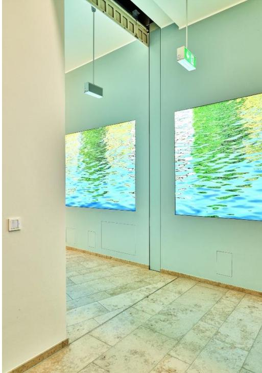
**Bild 5:** Die Oberfläche der Klappen des Feuerschutz-Schiebetores lassen sich farblich an die Umgebung anpassen, so dass das Tor praktisch unsichtbar im Gebäude verschwindet.
