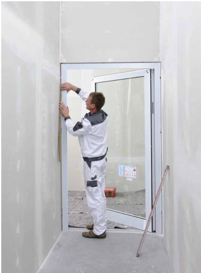
Bild 3: Brandschutztüren müssen unter anderem mit Mineralwolle hinterfüllt werden, um den Brandschutzanforderungen gerecht zu werden.
