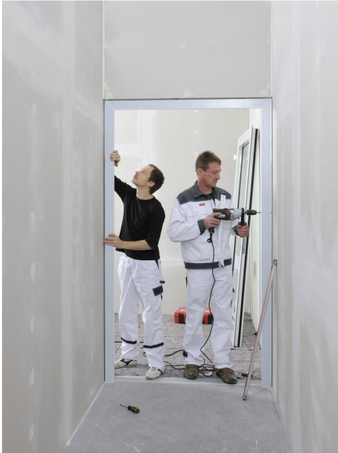
Bild 4: Für den Einbau von Türen ist die richtige Montage der Zarge entscheidend. Sie muss hinterklotzt und fluchtgerecht ausgerichtet werden.
