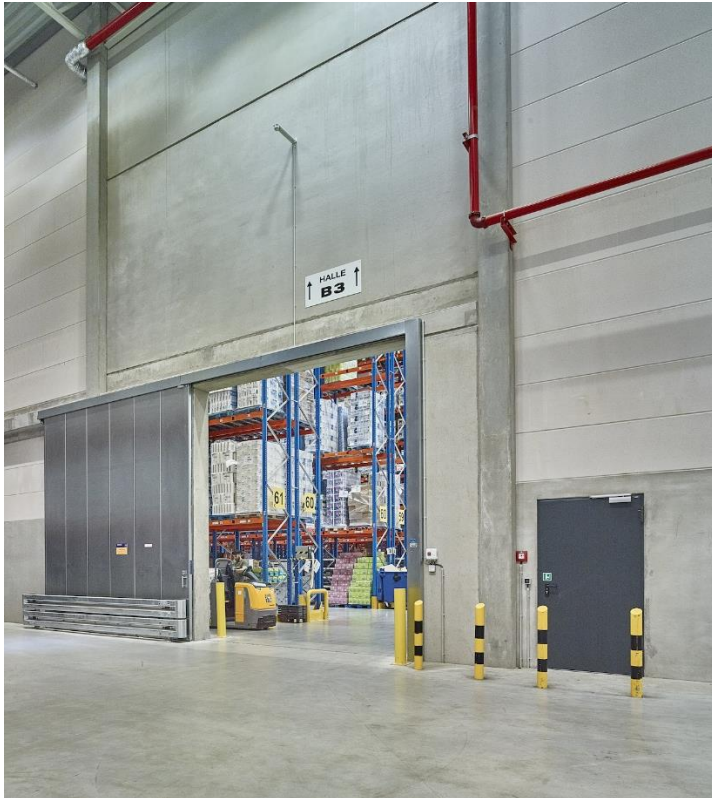
Bild 10: Im Brandfall sorgen 58 einflügelige Hörmann Feuerschutz-Schiebetore vom Typ FST 90-1 für Sicherheit. Die daneben liegende Brandschutztür des Herstellers sichert den Fluchtweg für die sich im Gebäude befindenden Personen.
