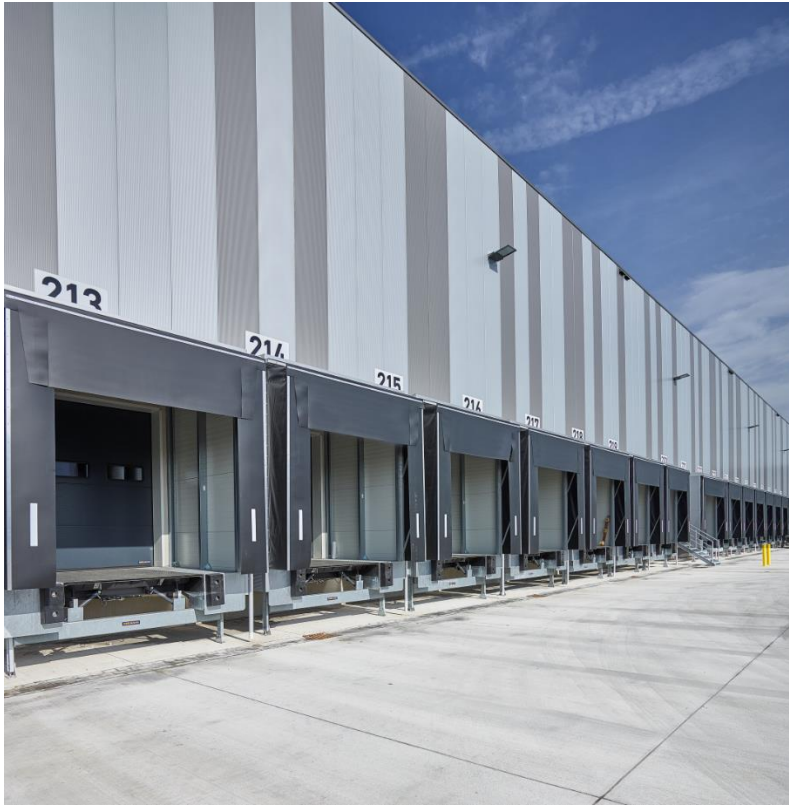
Bild 5: Für den Metro Logistikpark lieferte Hörmann unter anderem 407 Industrie-Sectionaltore mit Ladebrücken und Vorsatzschleusen.
