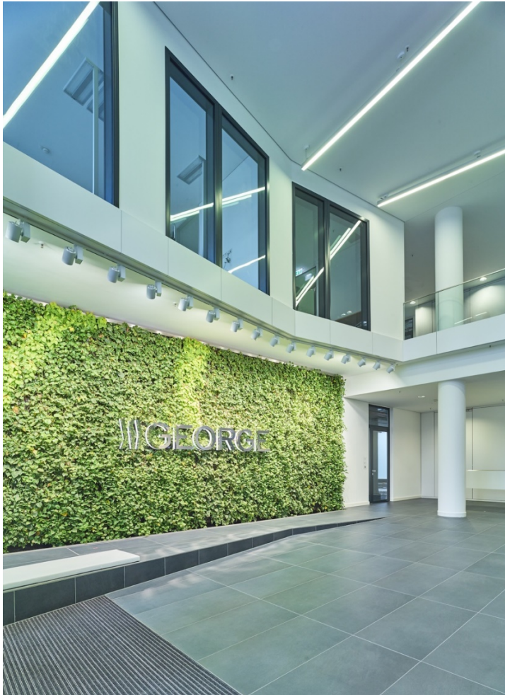
Bild 5: In der über zwei Geschosse verlaufenden Lobby sorgen hochwertige Materialien, vertikale Wandgärten und absturzsichere F30 Durchblickfenster von Hörmann für eine repräsentative Atmosphäre.
