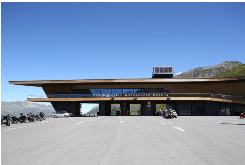
Bild 3: Die Timmelsjoch Hochalpenstraße verbindet das hintere Ötztal mit dem Südtiroler Meran, die Mautstelle wurde in den Neubau integriert.
