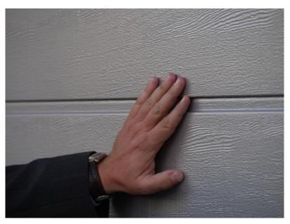
**Bild 5:** Garagen-Sectionaltore sollten über einen Fingerklemmschutz verfügen, damit die Finger beim Schließen des Tores nicht zwischen den einzelnen Tor-Sectionen eingequetscht werden können (im Bild: neues Tor mit Fingerklemmschutz).
