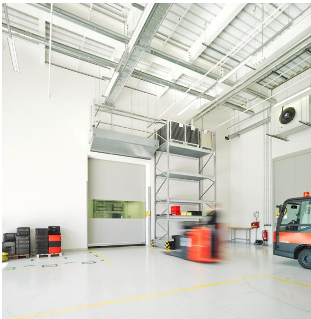
Bild 9: Die flexiblen Schnellauftore von Hörmann sind das verbindende Element zwischen der Versandabteilung und den Produktionshallen – für einen reibungslosen Betriebsablauf öffnet der Behang mit einer Geschwindigkeit von 2 m/s.
