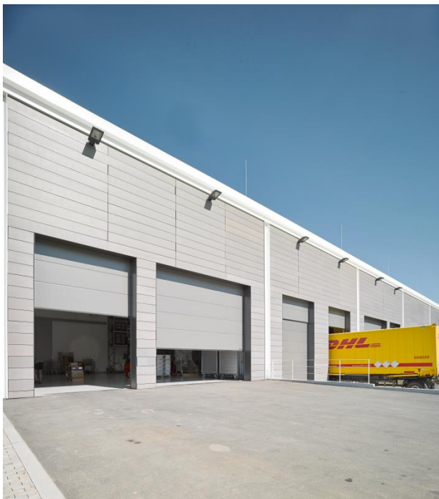
Bild 5: Die gedämmten Industrie-Sectionaltore SPU F42 von Hörmann sind den Verladebrücken vorgeschaltet und fügen sich durch eine Sonderlackierung nahtlos in das Fassadenraster ein.
