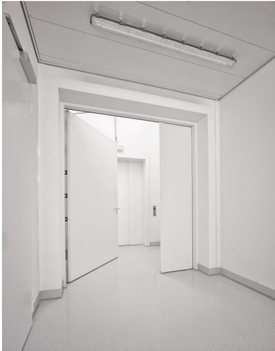
Bild 8: Weiß in weiß – hinter der zweiflügeligen Stahl-Feuerschutztür von Hörmann versteckt sich der Aufzug.
