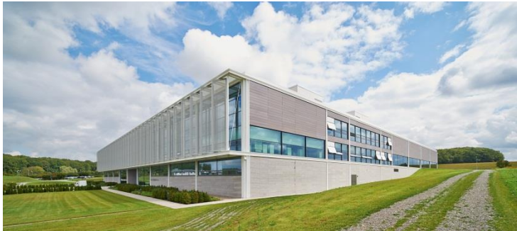
Bild 6: Nachhaltige Resystapaneele und Muschelkalk-Natursteinplatten bekleiden die hochwärmegedämmte Gebäudehülle. Die transparenten Bereiche sind mit einer Dreischeiben-Wärmeschutzverglasung versehen.
