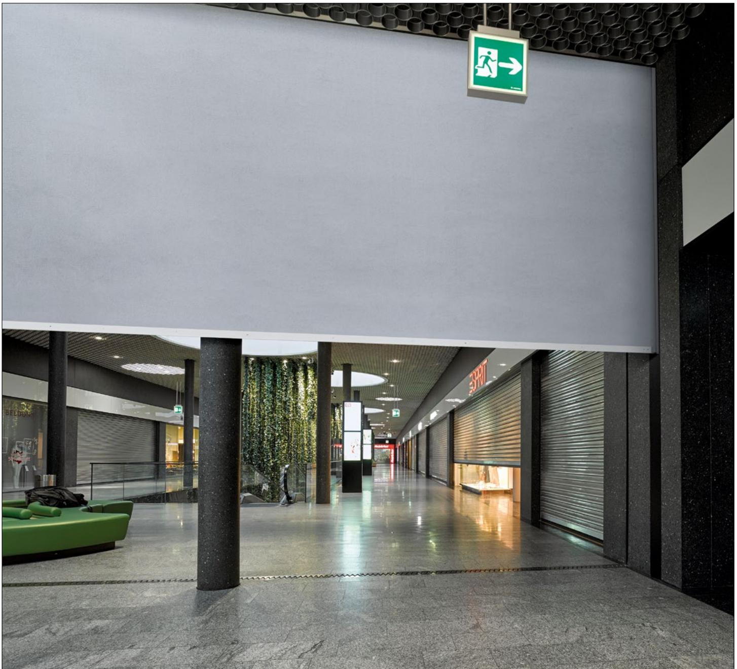
**TEXTIL-FLEXIBLER FEUERSCHUTZABSCHLUSS MIT CE-KENNZEICHNUNG.** Die textil-flexiblen Feuerschutzabschlüsse werden gemäß den europäischen Anforderungen im Brandschutz geprüft und erfüllen die Produktnormen EN 16034 und EN 13241. Das bedeutet für Sie: Die Produkte können somit innerhalb der EU in jedem Land in Verkehr gebracht werden. Landesspezifische Zulassungen oder Nachweise sind nicht mehr erforderlich.
