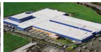
Hörmann KG Ichttershausen, Allemagne
