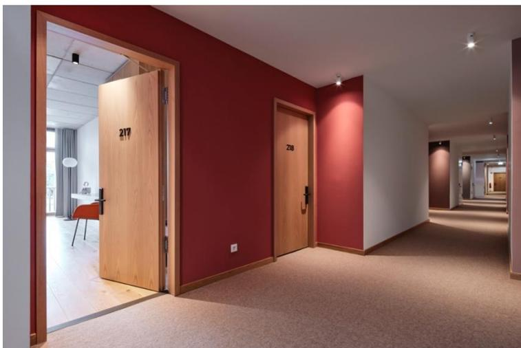
**Bild 5:** Auch große Formate, ein- oder zweiflügelig bis 2250 x 2500 mm, und hohe Türgewichte bis 100 kg sind realisierbar.
