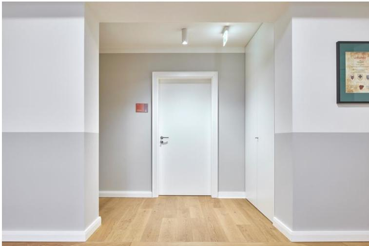
**Bild 4:** Die zweiteilige Zarge von Schörghuber ist individuell anpassbar, etwa in den Spiegelbreiten, der Oberflächenvielfalt und der flächenbündigen Optik.
