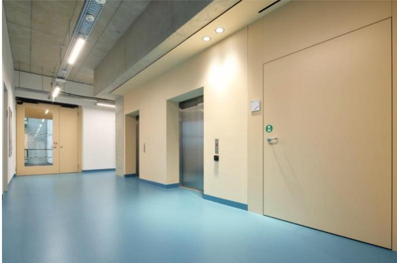
**Bild 7:** Die erforderlichen Durchgangsbreiten werden teilweise über überdimensionierte, einflügelige Türen gewährleistet. Die Türen wurden in zwei Teilen gefertigt und vor Ort zusammengesetzt, um Stabilität und Funktionalität zu gewährleisten.
