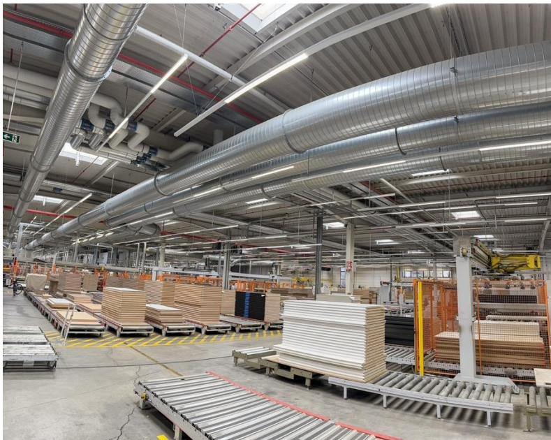
Bild 2: Mit Umstellung auf LED als Beleuchtungsmittel sowie der Einführung einer tageslichtabhängigen Beleuchtungssteuerung in der Produktion von Schörghuber am Standort in
