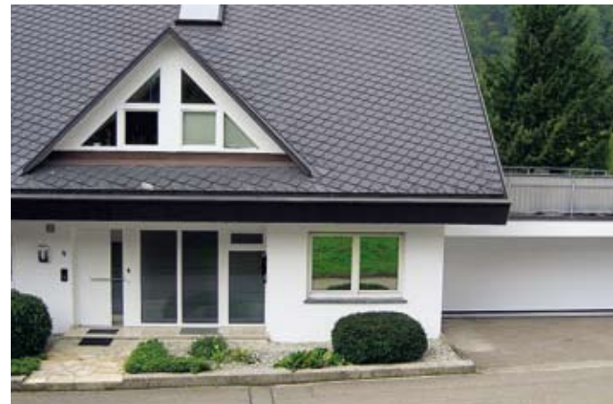
Weil mit der neuen Haustüranlage alles so gut geklappt hatte, ließen sich die Hildbrands auch noch ein neues Garagentor mit Antrieb vom selben Hersteller einbauen.
