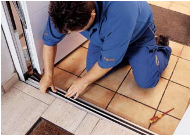
Wenn bei der Schwelle alles passt und ausgerichtet ist, wird die bisher sichtbare Befestigungsebene nochmals mit einem Verblendungsprofil abgedeckt.
