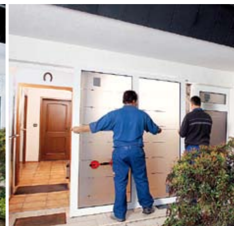
Jetzt werden die Seitenteile mittels Kopplung mit dem Haustürrahmen zusammengeführt und verschraubt.
