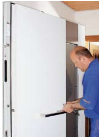
Der Türgriff wird montiert, die Funktion der Tür geprüft und in Betrieb genommen.
