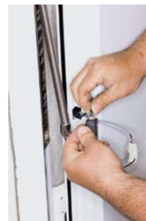
Die Verkabelung des Scanner-Schlusses wird an der Bandseite verbunden.
