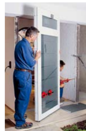
Mauerwerk wird angepasst. Seitenteil wird eingestellt, um die Flucht zu prüfen.
