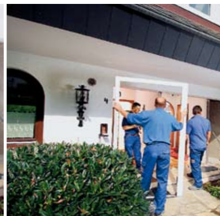
Der Türflügel wurde aus dem Rahmen ausgehängt, der Bodeneinstand entfernt und für die Montage vorbereitet.
