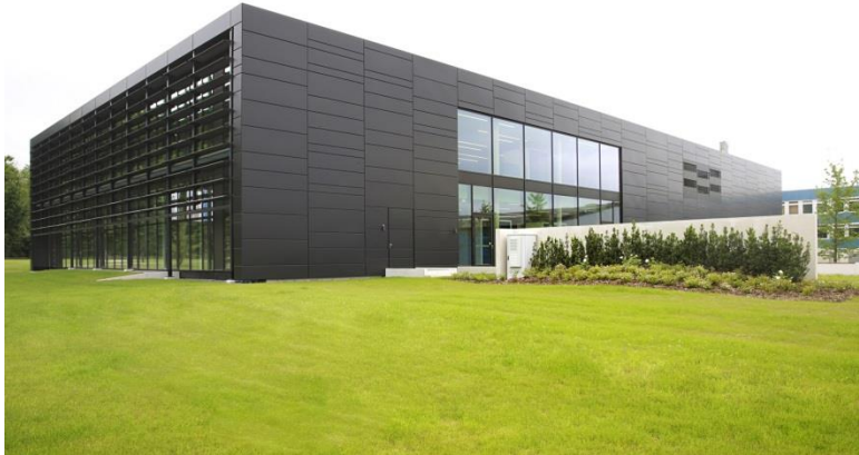
Bild 2: Ansicht von hinten mit Blick auf den „Energiegarten“, in dem der Einsatz von Wärmepumpen im Außenbetrieb getestet wird.
