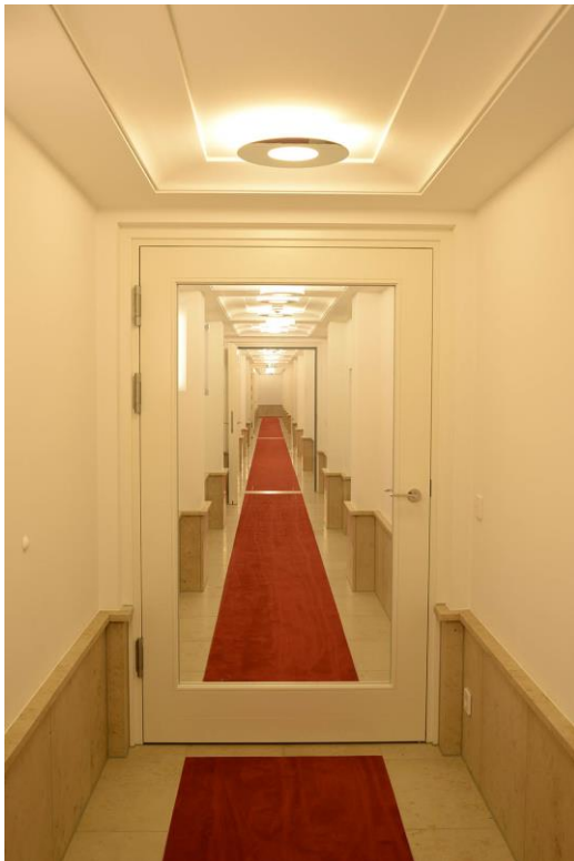
Bild 5: In der fünften und sechsten Etage führen geradlinige Flure zu den Luxuswohnungen. Massivholz-Rahmentüren von Schörghuber sorgen mit großen Glasflächen für Transparenz und gewähren zugleich Brand-, Rauch- und Schallschutz.
