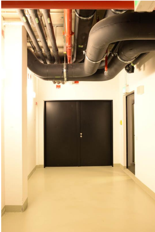
Bild 6: Überwiegend im Untergeschoss des Palais an der Oper kamen Hörmann Stahlblechtüren zum Einsatz. Je nach Anforderung wurden sie mit Feuer- und Rauchschutzfunktion ausgestattet.
