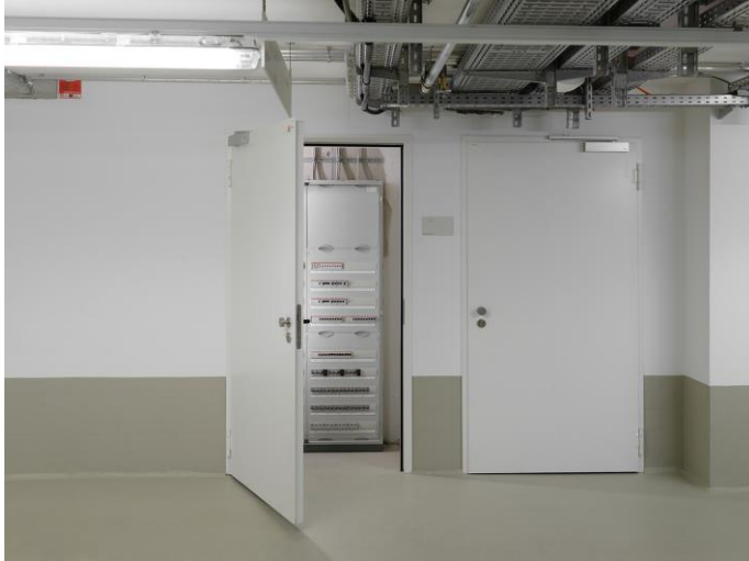
Bild 7: Von der Tiefgarage aus sind die Technikräume durch weiß lackierte Stahlblechtüren mit Dünnfalz zu erreichen. Die Türen sind feuerhemmend und rauchdicht.
